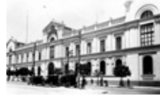
P. 45 C. 1929 CAF, SUB COLECCIÓN INSTITUCIONAL Antes de la instalación del reloj en el frontis, ese mismo año.
