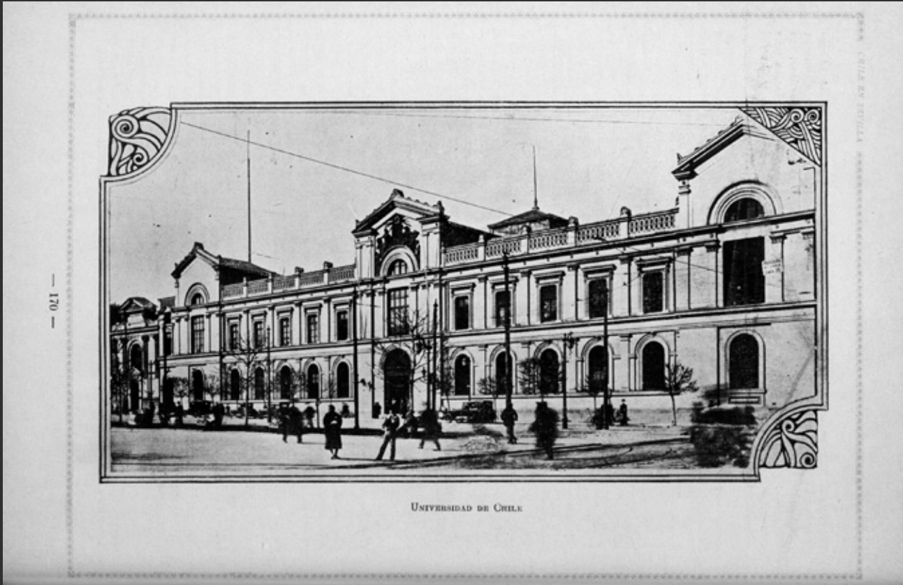
Reproducción. Palacio de la Universidad de Chile, fachada. Se aprecia la antigua biblioteca unificada del Instituto Nacional y la universidad (ex-iglesia de San Diego) y modificaciones paisajísticas. Los álamos han sido reemplazados por árboles más pequeños. Aparece el trazado del tranvía eléctrico, mientras los transeúntes caminan por la acera y la plaza central en la Alameda. C. 1920.
