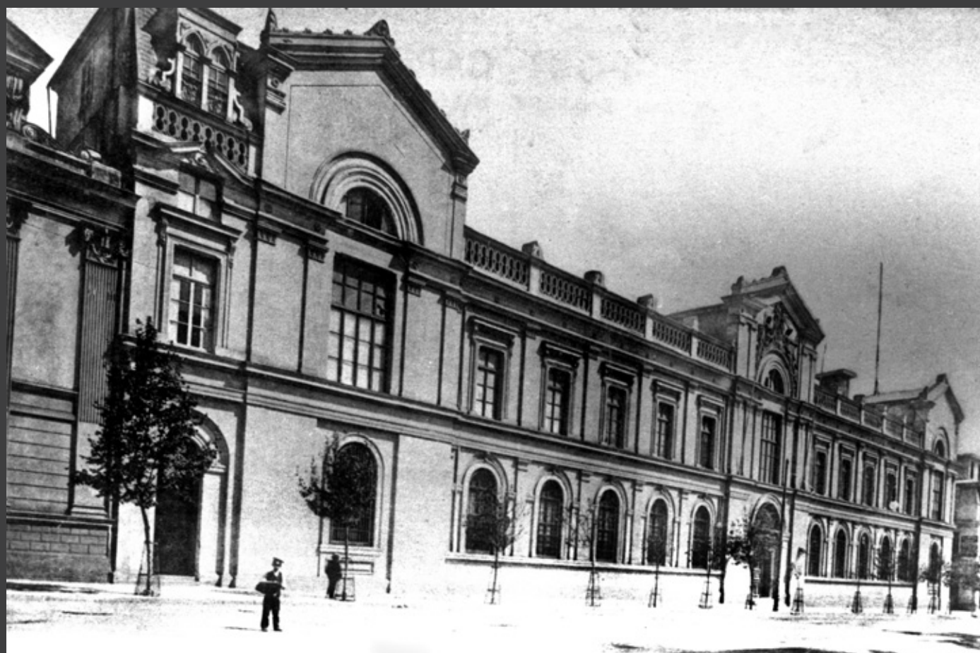
Palacio de la Universidad de Chile, vista de la fachada. A la izquierda alcanza a verse parte del edificio de la biblioteca compartida entre la universidad y el Instituto Nacional. En seguida, el angosto edificio de tres plantas donde funcionaba un cuartel de bomberos. En el extremo derecho se divisa la entrada de calle San Diego y un edificio comercial en la esquina opuesta. C. 1915.
