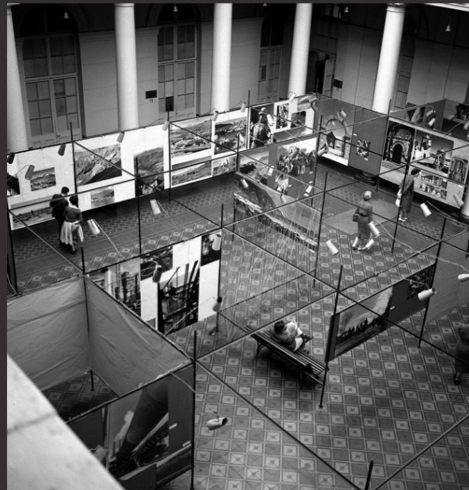
Perspectiva superior de la exposición Rostro de Chile ubicada en los patios de Casa Central. La toma capturada desde el segundo piso del edificio permite apreciar la estructura metálica que sostuvo el montaje, su diseño, recorrido y organización. 1960.
