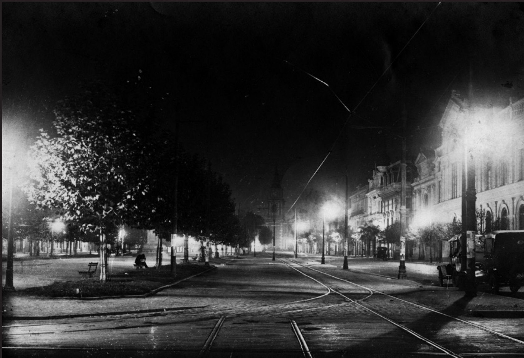
Vista nocturna de la Alameda, desde el poniente, sector frente a la edificio principal de la Universidad de Chile. Destacan la luminaria pública y el trazado del tranvía eléctrico. Al fondo, la Iglesia de San Francisco. C. 1927.
